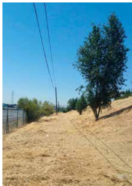
El mismo lugar una vez realizado el desbroce.
