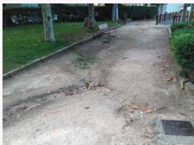
Se arreglarán todos estos paseos del parque de la Avda de Madrid, instalando una correcta línea de drenaje.
