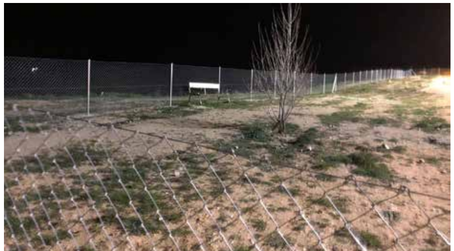
En este ZOC se ha aprovechado el soporte de la farola existente para instalar un proyector que iluminara el parque canino.jpg
