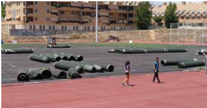
A mediados de junio comenzaron las obras para cambiar el césped del campo de fútbol. El concejal de Deportes, Roberto Ronda, aprovechó para visitar las obras y las pistas de atletismo.
