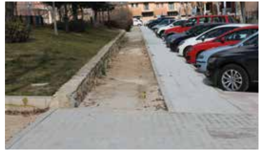
► Obras solado en parque Los Arroyos.
