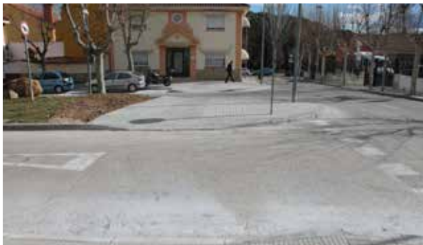
► Nuevo solado y acerado según recoge la ley de accesibilidad en toda la calle Andalucía.
