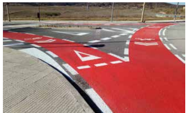
► Finalizada la señalización y pintura acústica de los 4 km del carril bici urbano.
