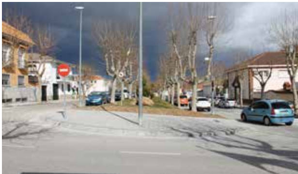
► Accesibilidad peatonal en zona del mercadillo.
