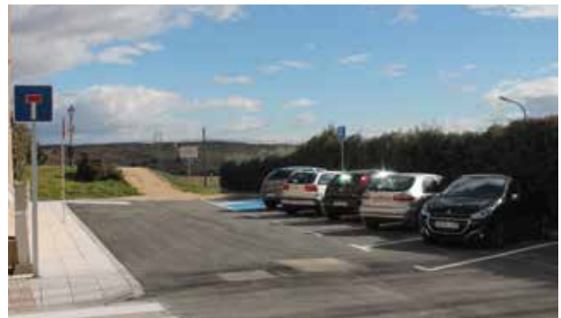
► Realización de un nuevo aparcamiento de 7 plazas en la zona Los Arroyos.
