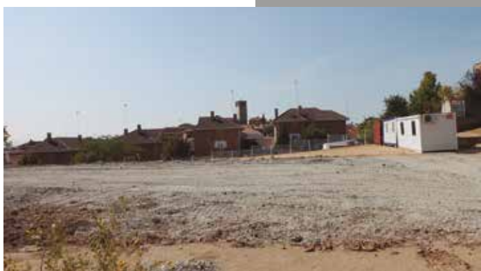
Obras del Pabellón Polideportivo
