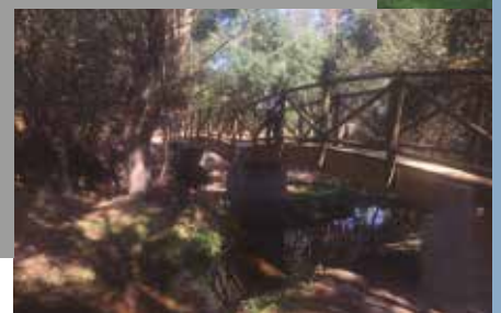
Uno de los dos puentes contemplados en el Proyecto de la Ciclovía
