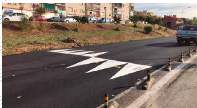
Además de pasos peatonales, también han realizado pasos elevados para regular la velocidad en la M104
