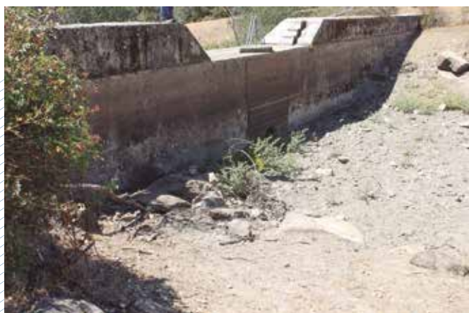
Así se encontraba la presa de la Nava antes de acometer las mejoras
