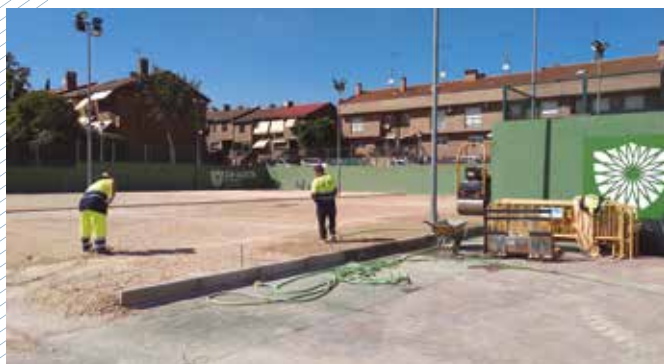
La elevación del terreno de las pistas hasta donde se encuentra el desague ha sido el segundo paso de las obras
