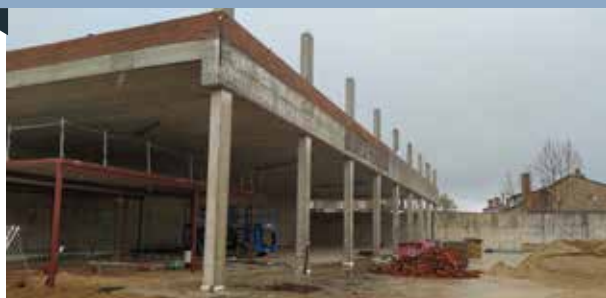
Las obras del Pabellón Polideportivo Navalazarza a fecha 16 de marzo
