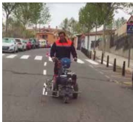
Desde septiembre, se está procediendo a realizar labores de pintura de pasos de peatones y señalética
