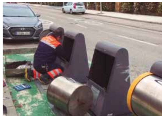
Labores de supervisión y mantenimiento de los contenedores soterrados
