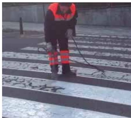
Se están realizando mejoras de la pintura de los pasos de peatones en peor estado
