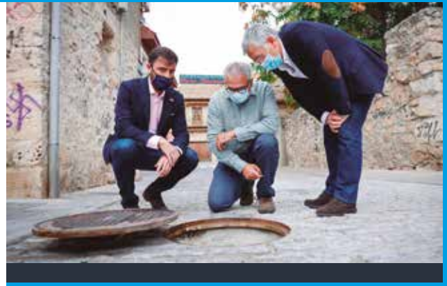
Comprobación de un pozo de válvulas de fundición en lugar de las de fibrocemento que había antes. Unas tuberías más seguras para la salud de los vecinos.
