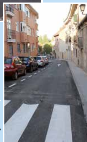
Finalizado el asfaltado de la calle Soledad
