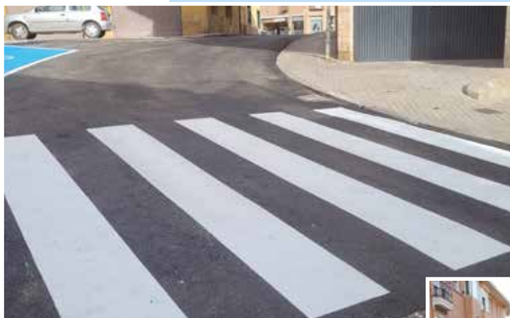
Finalización del pavimento de la calle Cuatro Calles Finalización del pavimento de la calle Cuatro Calles
