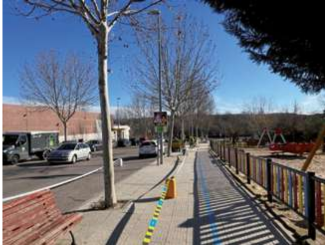
Mejora del acerado levantado en calle Lorenzo Ginés Brandín alrededor de los alcorques
