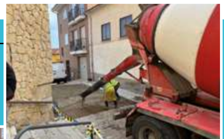
Arreglo viario y acerado detrás de la iglesia
