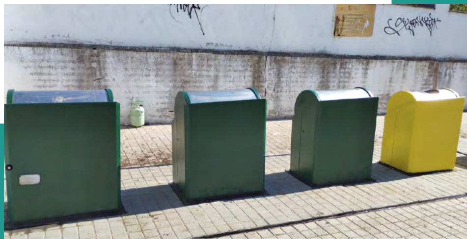
Reparación y mantenimiento de 15 soterrados en SAU 1 y SAU3
